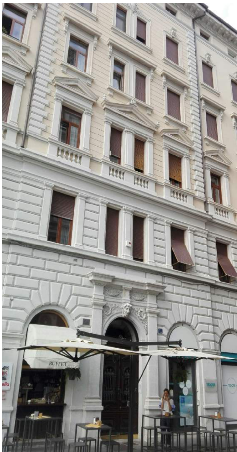
FOTO 1 – Facciata palazzo prospiciente via Genova 11
